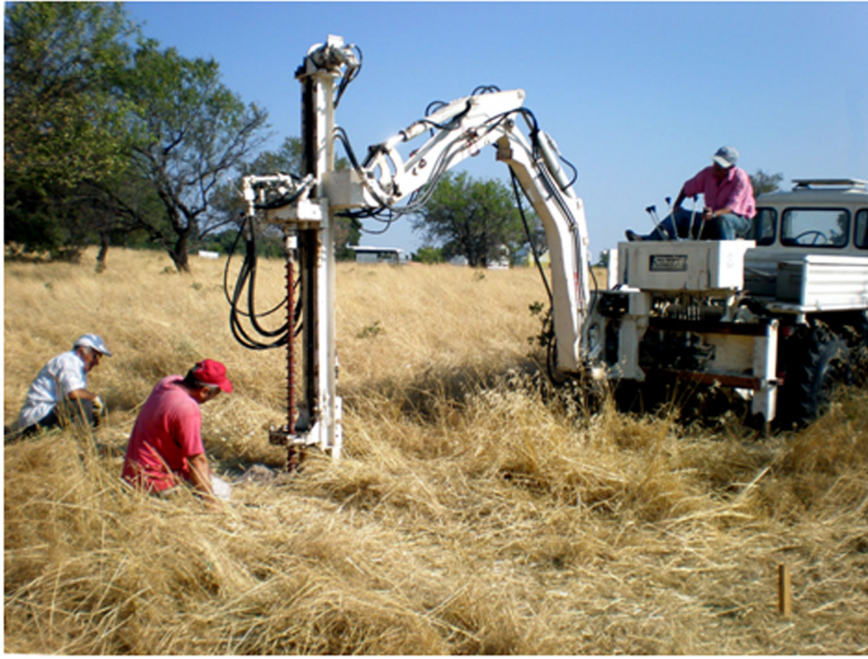
Fig. 4. Unimog iş makinesi ile yapılan burgu-delgi (auger drilling) çalışmaları.
